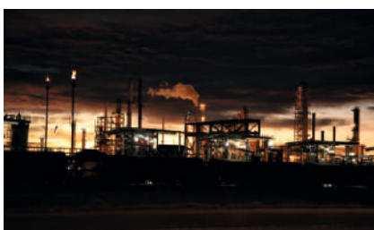
Освещение электросталеплавильного цеха ОАО «Оскольский электрометаллургический комбинат», г. Старый Оскол, 2019 г.
