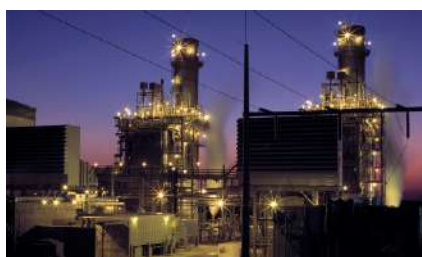
Освещение газопоршневой электростанции ГПЭС-3 АО «Карабашмедь», Челябинская область, 2022 г.
