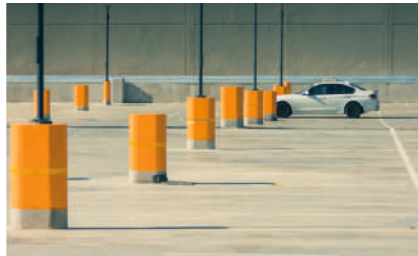
Освещение дорог и автостоянок на территории ООО «Тобольск-Полимер», 2013 г.
