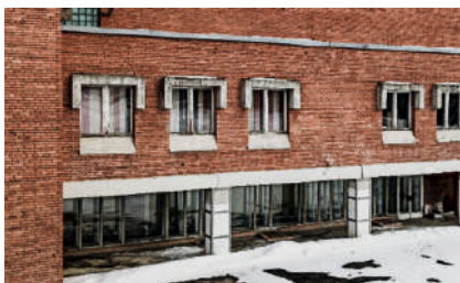
Наружное освещение Воинской части №3526, п. Лебяжье, Ленинградская область, 2016 г.
