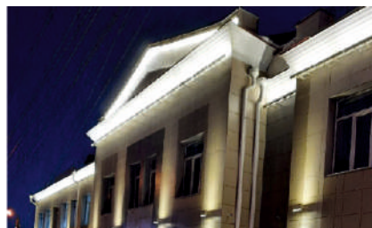
Архитектурно-художественное освещение фасадов здания «Детской художественной школы искусств» МАУДО «ДХШИ» г. Челябинск, 2022 г.
