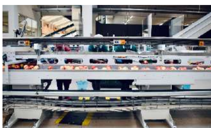
Строительство цеха хранения и переработки ООО «Грин Рэй Кубань» (Green Ray), Краснодарский край, 2023 г.
