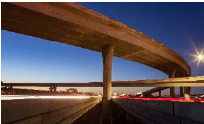
Освещение путепроводов, для обеспечения транспортной безопасности на автодороге Екатеринбург-Аэропорт «Кольцово», г. Екатеринбург 2023 г.
