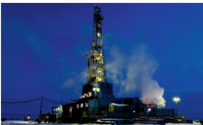
Инфраструктура западного Салымского месторождения ООО «Салым петролеум девелопмент», г. Салым, ХМАО, 2022 г.
