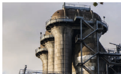
Освещение склада ООО «Алексеевский соевый комбинат» (ГК «ЭФКО»), Белгородская область, 2018 г.
