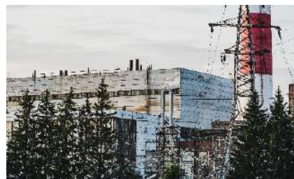
Зайкинское ГЗПП (газоперерабатывающее предприятие) ПАО «Роснефть», г. Бузулук, Оренбургская область, 2023 г.
