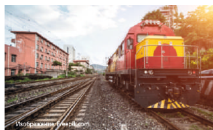
Освещение железнодорожной станции «Тамань-Пассажирская», ст. Тамань, 2019 г.
