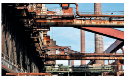
Реконструкция цехов АО «Суходожский литейно-механический завод» (АО «Суходожское Литье»), Свердловская область, 2019 г.
