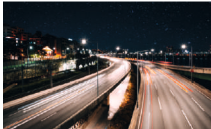
Освещение автодороги Тамбов-Пенза, 2013-2014 гг.
