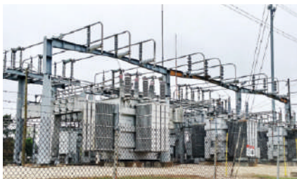
Освещение электрической подстанции энергомоста в Крым, Краснодарский край, станция Тамань, 2016 г.
