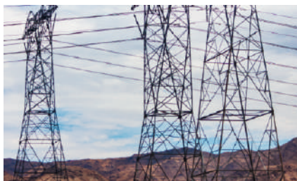
Строительство и реконструкция объектов электросетевой инфраструктуры г. Тюмень, ОАО «ФСК ЕЭС», 2021 г.
