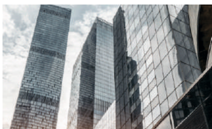
Наружное освещение технопарка ПАО «Сбербанк», Сколково, 2017 г.
