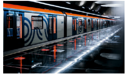
Освещение тоннелей метрополитена депо «Лихоборы», г. Москва, 2018 г.
