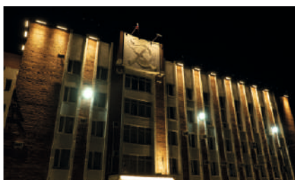
Наружное (архитектурное) освещение Администрации Калининского района, г. Челябинск, 2020 г.
