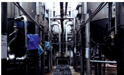
Строительство содового завода АО «Новотроицкий завод хромовых соединений» (АО «НЗХС»), г. Новотроицк, Оренбургская область, 2022 г.
