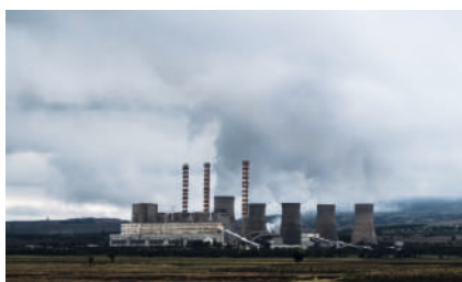
Освещение Аргаяшской ТЭЦ, п. Новогорный, 2020 г.
