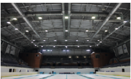
Освещение многофункциональной арены «Ледяной куб», г. Сочи, 2017 г.
