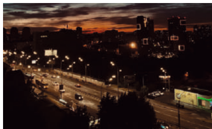
Устройство освещения автомобильной дороги и пешеходных дорожек на дороге общего пользования регионального значения «Астрахань-Камызяк», ГКУ АО «Астраханьавтодор», 2019 г.
