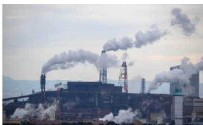
Освещение ОАО «Лужский абразивный завод», п. Луга, 2020 г.
