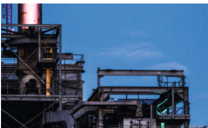
Освещение производственных помещений и железнодорожных путей парка отстоя вагонов АО «Каустик», г. Волгоград, 2013 - 2020 гг.
