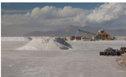
Периметральное освещение АО «Кнауф Гипс Баскунчак», Астраханская область, 2023 г.
