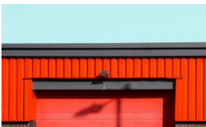
Наружные сети электроснабжения автоматизированного складского комплекса для хранения мороженой рыбопродукции и морепродуктов, Мурманская область, 2023г
