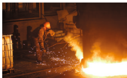
Замена освещения высокотемпературных цехов ООО «Медногорский медно-серный комбинат» (ООО «УГМК-Холдинг»), Оренбургская область, 2020-2021 гг.
