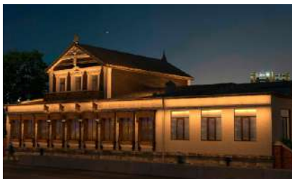
Дом в котором в ноябре-декабре 1917 г. находился Челябинский городской комитет РСДРП и революционный штаб охраны города, г. Челябинск, ул. Труда 88, 2023 г.
