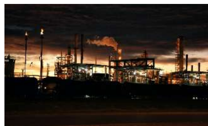
Система охранного освещения склада ГСМ Нефтебазы, ООО «ЛУКОЙЛ-Ухтанефтепереработка», Республика Коми, 2023 г.
