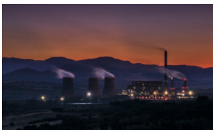
Модернизация освещения Балаковской АЭС, Саратовская область, 2012-2018 г.
