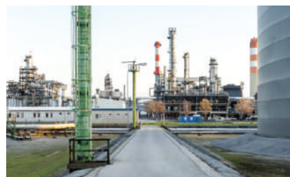
Освещение производственных площадей и территории АО «ЧЭМК», г. Челябинск, 2018 - 2023 гг.
