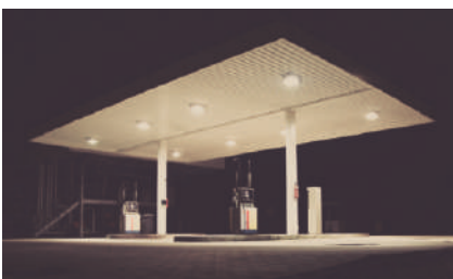
Освещение строящегося многофункционального дорожного сервиса и торгового центра-ресторана быстрого питания АЗС ПАО «Газпром нефть», г. Санкт-Петербург, 2021 г.
