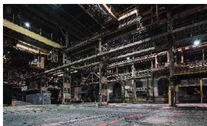
Реконструкция освещения плавильного, гальванического, производственного цехов на предприятии АО «Авиаавтоматика», г. Курск, 2023 г.
