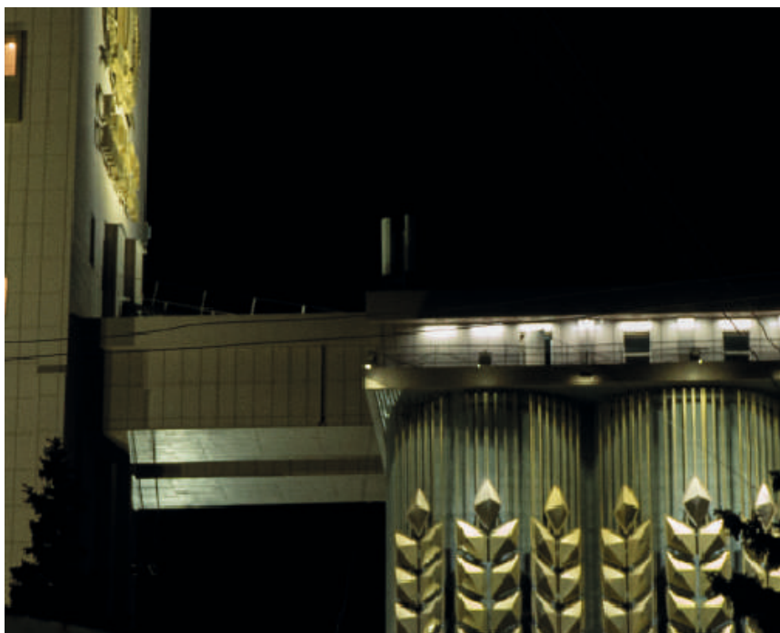
Освещение здания цеха №9, №8 ООО «Объединение «Союзпищепром», г. Челябинск, 2020 г.
