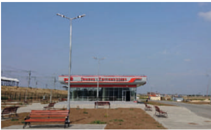
Освещение железнодорожной станции «Вышестеблиевская», Краснодарский край, 2019 г.
