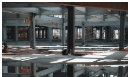
Освещение строящегося цеха и АБК ПАО «УралХимПласт», г. Нижний Тагил, 2021 г.
