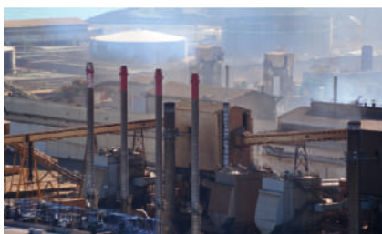
Освещение территории ОАО «Ковдорский ГОК», г. Ковдор, Мурманская область, 2014 г.
