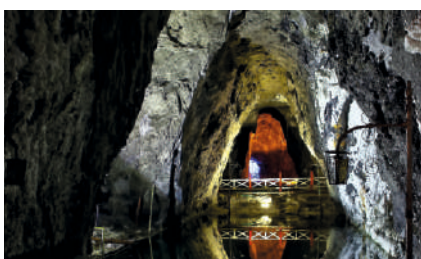
Реконструкция Ново-Учалинского подземного рудника, АО «УЧАЛИНСКИЙ ГОК», Республика Башкортостан, 2021 г.
