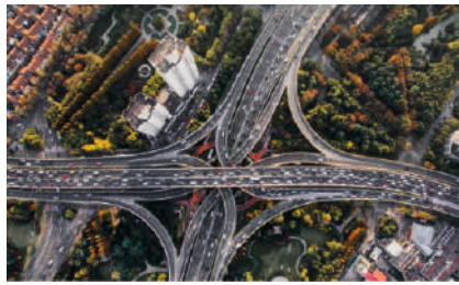
Освещение развязки ул. Федюниного-Мельникайте, г. Тюмень, 2016 г.
