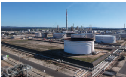
Реконструкция наружного освещения промышленной площадки «Грушовая» ООО «МонтажТехСтрой», Краснодарский край, 2021 г.
