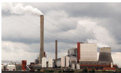
Освещение Белорусская АЭС, 2017 г.
