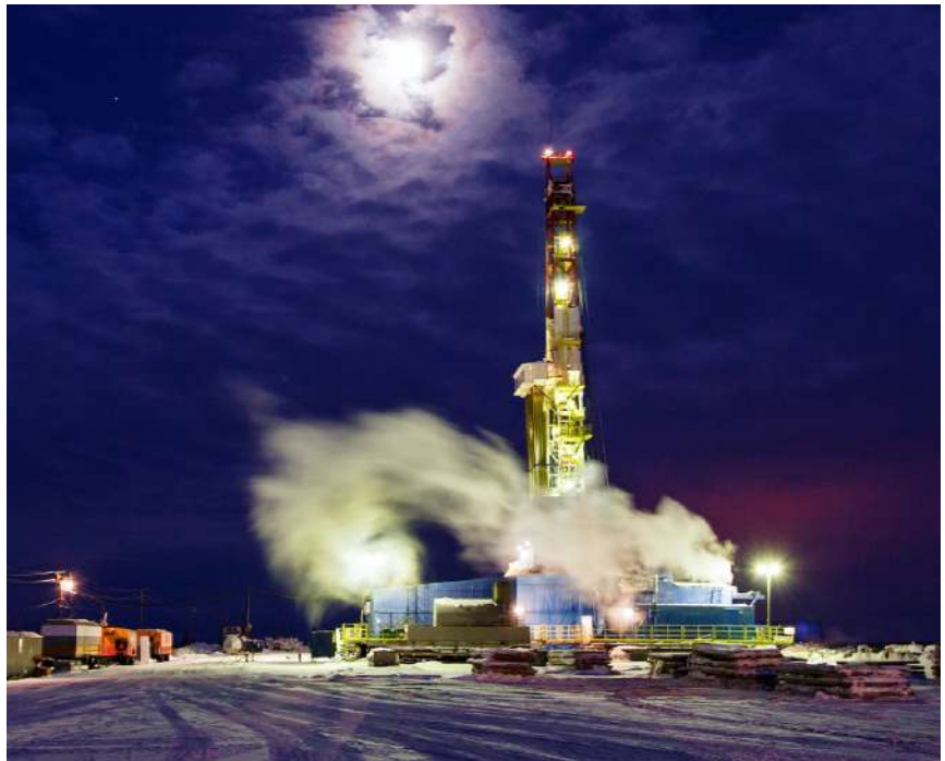
Замена вышедшего из строя оборудования на месторождении НГДУ «Быстринскнефть»
