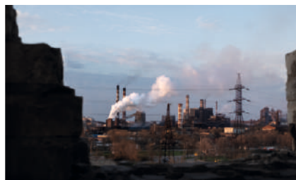
Замена освещения ООО «Абинского Электрометаллургического завода», г. Абинск, 2017 г.
