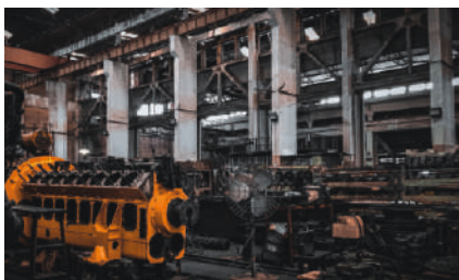
Освещение производственных площадей и прилегающей территории ЗАО «Шадринский автоагрегатный завод», г. Шадринск, 2013 г.
