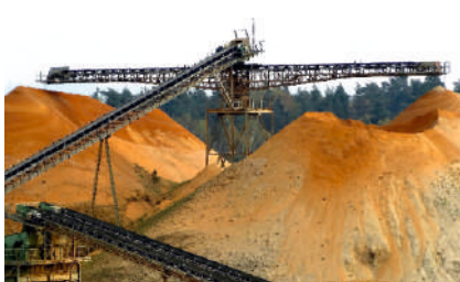
Строительство дробильно-сортировочной установки ДСУ ООО «Варнский дробильно-сортировочный комплекс», Челябинская область, 2022 г.
