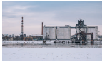
Освещение причальной зоны зернового элеватора ООО «Агропорт Устье Дона», Ростовская область, 2019 г.
