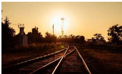
Строительство новой тяговой электрической подстанции «Солнечная», ОАО «РЖД», Московская область, 2023 г.
