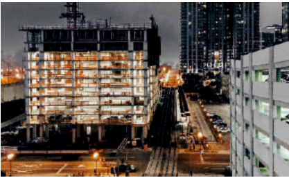
Уличное освещение строящегося жилого района «Гороховое поле», г. Магадан, 2022 г.
