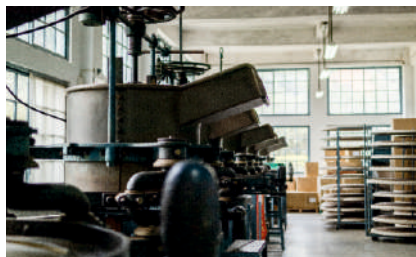
Взрывозащищенное оборудование для реконструкции цехов ООО «Галоген», г. Пермь, 2022
