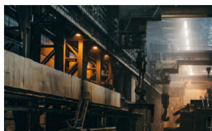
Модернизация освещения АО «Уралэлектромедь», г. Верхняя Пышма, 2020 г.
