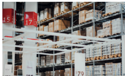
Реконструкция освещения завода ИКЕА, ООО «ИКЕА Индустри Вятка», пгт Красная поляна, Кировская область, 2015 г.
