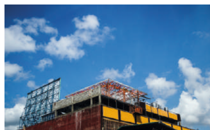
Замена производственного освещения ЗАО «Интернешнл Пейпер», г. Светогорск, Ленинградская область, 2016 г.
