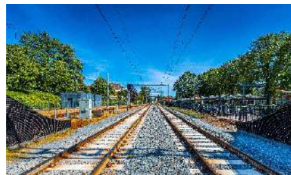
Освещение станции Москва-Пассажирская-Киевская. Москва пл. Киевского Вокзала 1, ОАО «РЖД», 2023 г.
