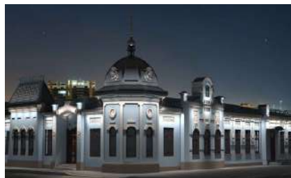
Архитектурно-художественное освещение фасадов здания объект культурного наследия регионального значения: Особняк Бреслина, г. Челябинск, ул. Пушкина д. 1, 2023 г.
